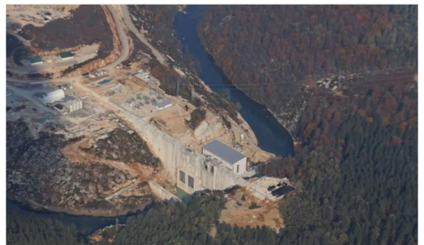
Das Lesce Wasserkraftwerk am kroatischen Fluss Dobra hat seit der Auftragsvergabe 2010 zahlreiche Probleme verursacht. © Goran Safarek
