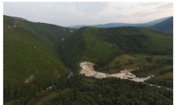
Medna Projekt an der Sana, gebaut vom Bauunternehmen Kelag. Foto: Za vode Podgorice
